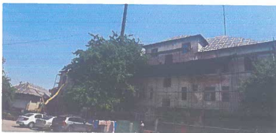
Lucrările continuă la șarpanta Substației Sighetu Marmației (imagini 15.07.2024).
