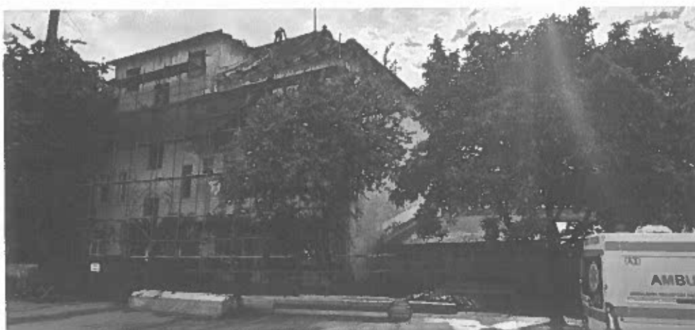
Lucrările continuă la șarpanta Substației Sighetu Marmației (imagini 14.06.2024).
